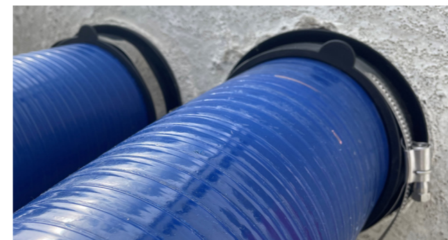
HSI150 KMA, Einfach-Dichtpackung mit klappbarer Gummimanschette, Anschluss Hafelex
