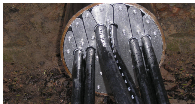
HRD200 G b30 in einem Stahlrohr
